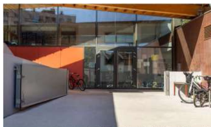
Porte étanche à l'entrée de l'école Diderot à Grenoble © Ville de Grenoble
