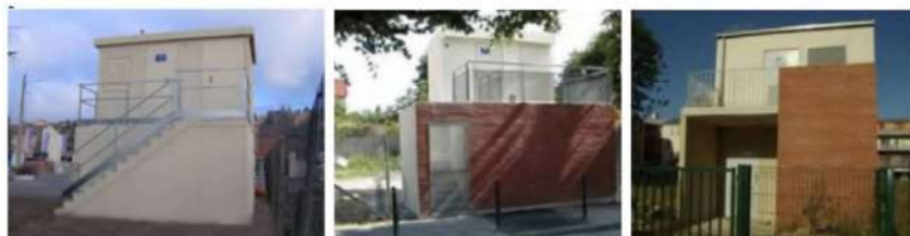
Postes de transformation électrique surélevés en zone inondable (© Enedis)
