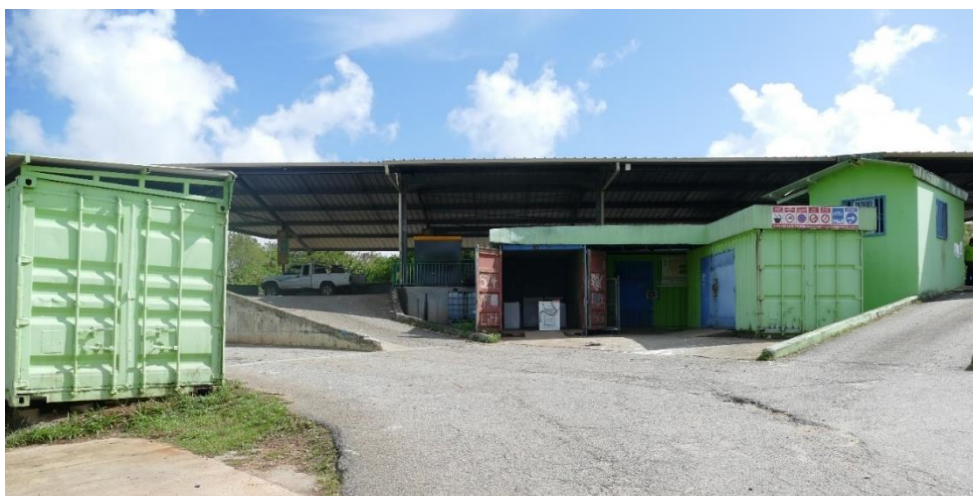
Photo : Entrée de la déchetterie de Rémire-Montjoly
