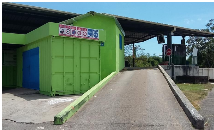
Photo : Entrée de la déchetterie de Rémire-Montjoly
