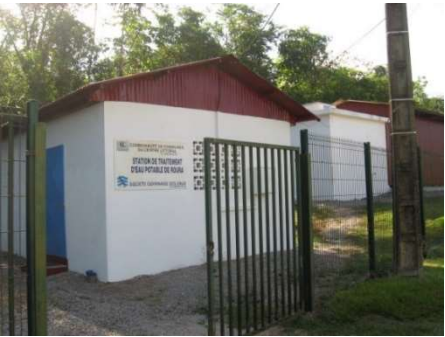
Figure 10: Usine de potabilisation du bourg de Roura
