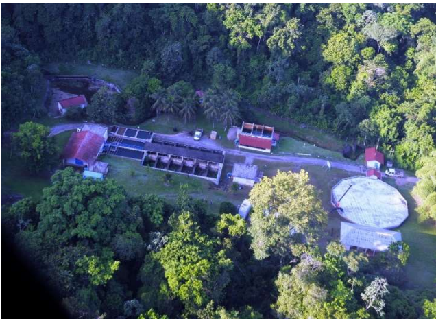
Figure 9: Photo en vue aérienne de l'usine du Rorota
