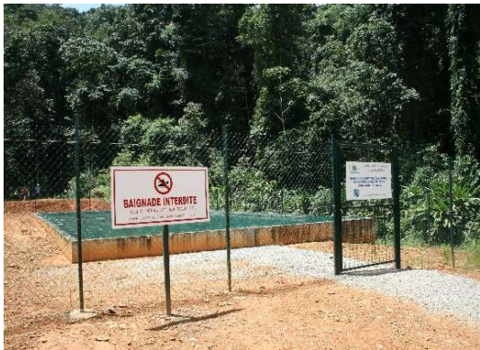
Figure 11: Captage de l'usine de Cacao
