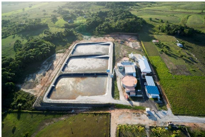
Figure 7: Photo en vue aérienne de l'usine de potabilisation de Matiti
