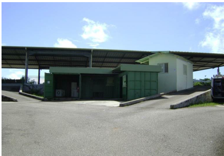
Photo 6 : Entrée de la déchetterie intercommunale
