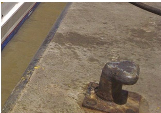
Remplacement des bollards
