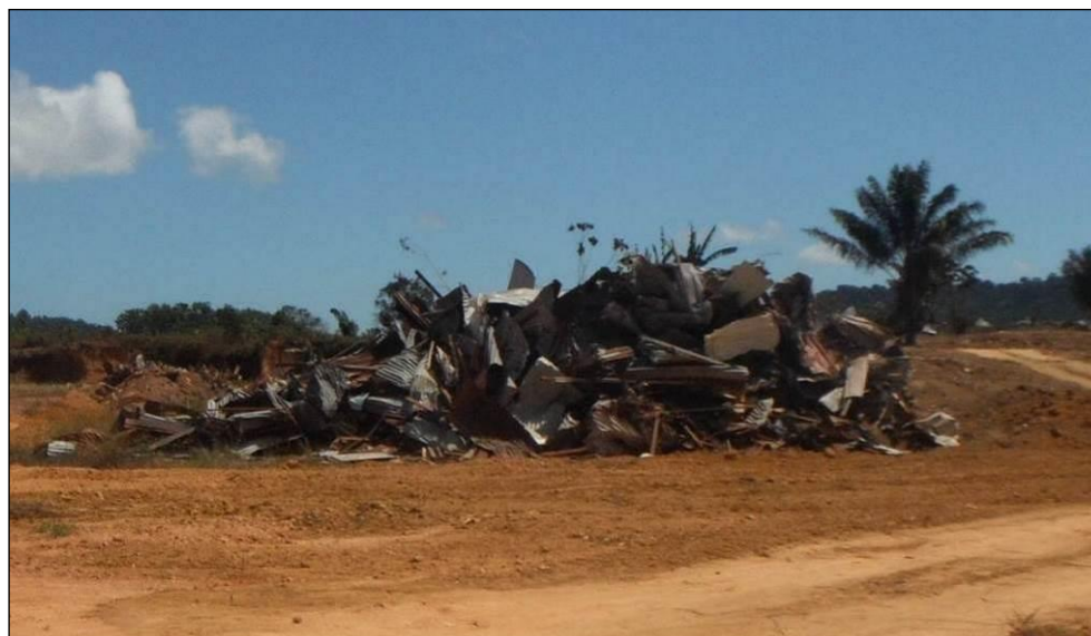
Figure 34 : Dépôts de déchets liés aux démolitions des constructions illégales
