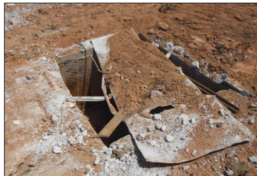
Figure 36 : Vestige de fosse septique sur la zone d'étude
